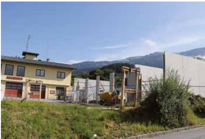
Der Bau des neuen Feuerwehrhauses geht gut voran! Nochmals danke an die Nachbarn für ihr Verständnis während der Bauphase!
